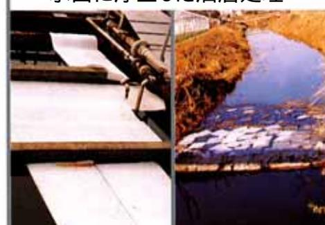
排水溝の浮上の油層処理
